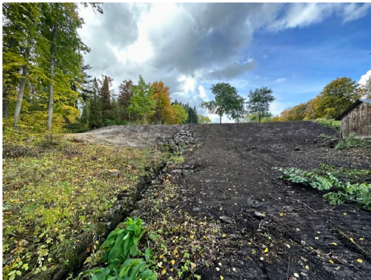
Canalens vall och dess stensatta utløpp och dike, sett från öster
